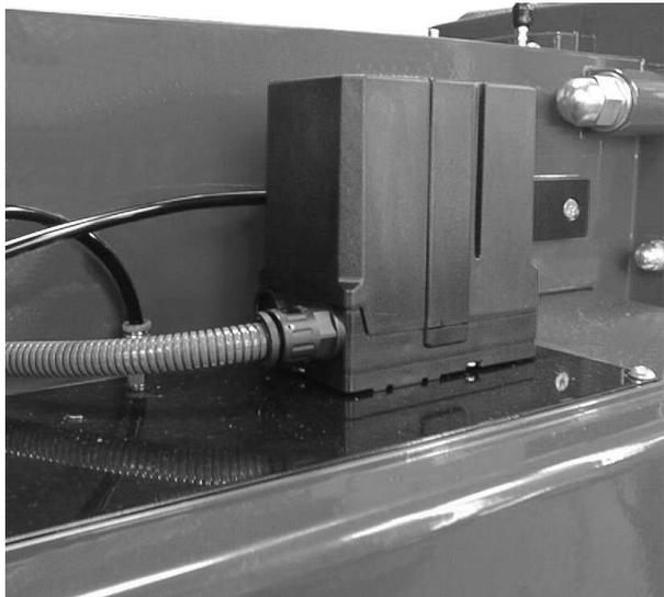
Сервопривод воздушной заслонки служит для установки положения воздушной заслонки при двухступенчатом, плавном и модулирующем режиме.
