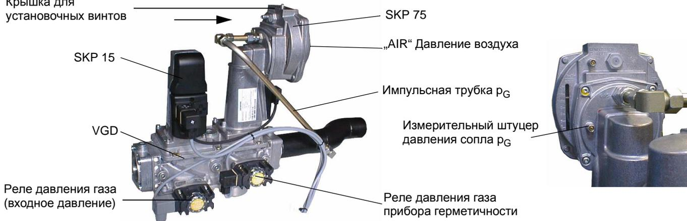
Присоединить голубую трубку „AIR“ газового блока с газовой обоймой горелки. Соединительная трубка должна пролегать в свободном изгибе.
